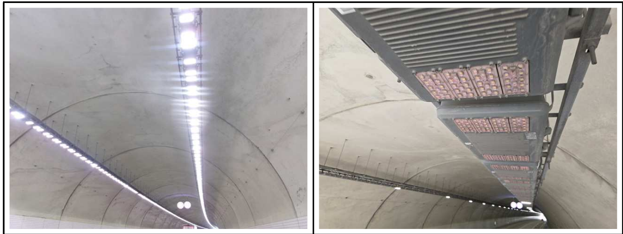
【사진 4.3.1】 천장부 전경
