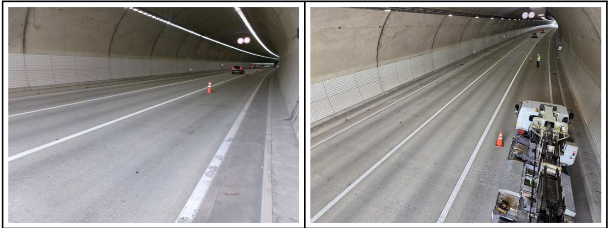
【사진 4.3.13】 포장부 전경
