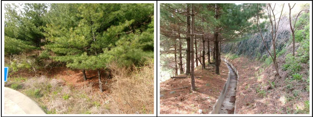
【사진 4.3.7】 사면 전경
