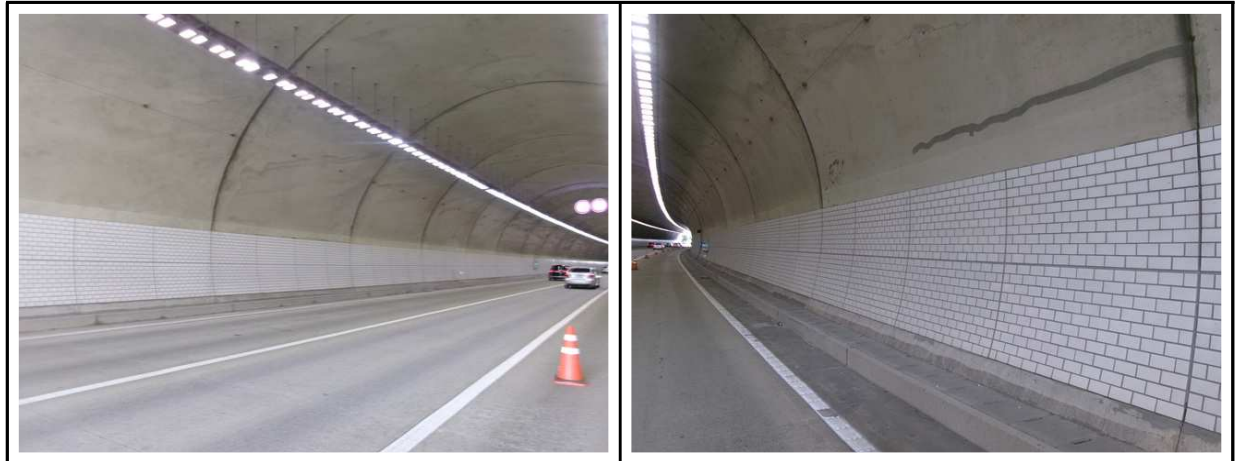
【사진 4.3.3】 측벽부 전경
