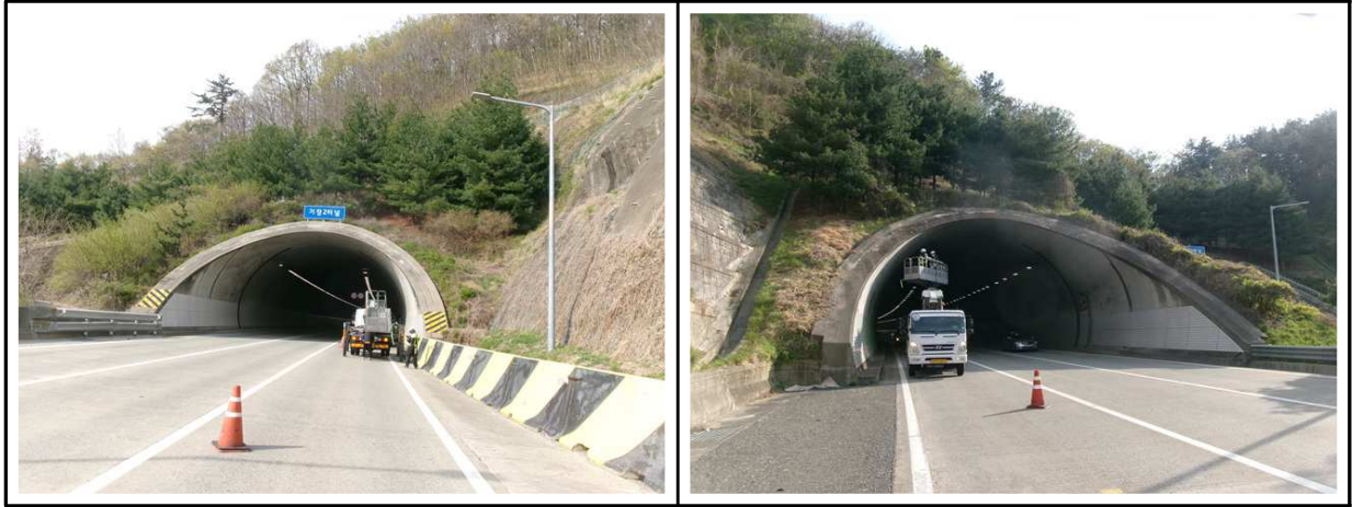
【사진 4.3.5】 갯문 전경
