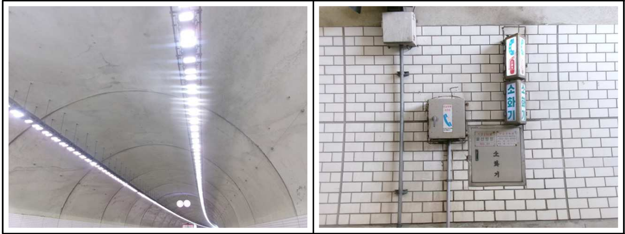
【사진 4.3.15】 기타부속시설 전경
