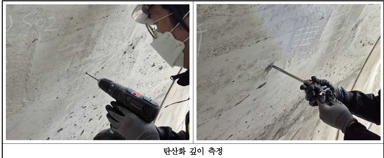
【사진 4.4.2】 탄산화 깊이 시험 현장사진
