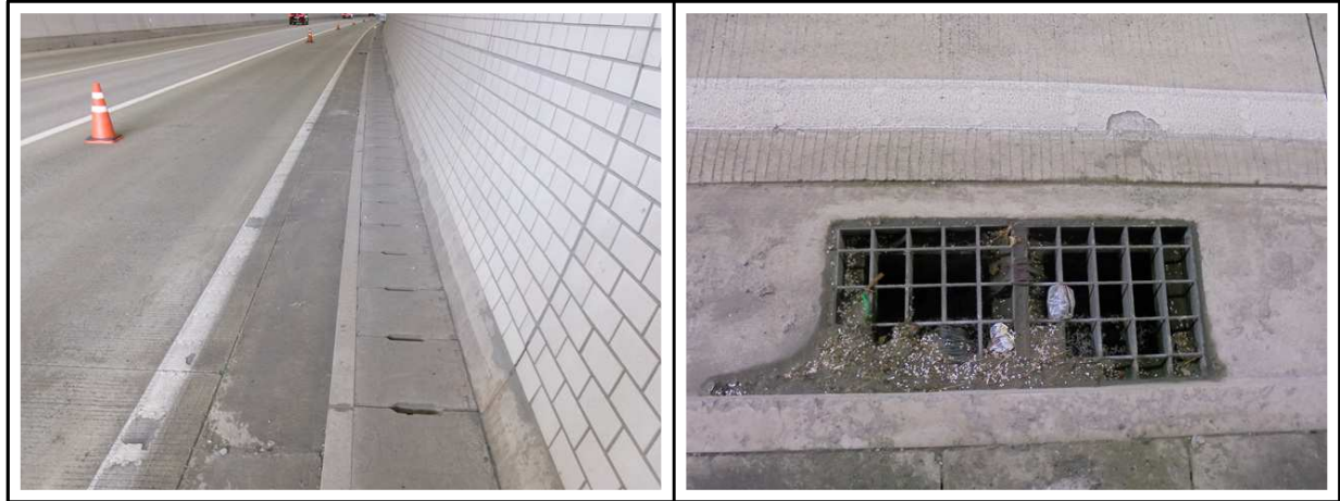
【사진 4.3.11】 배수시설 전경
